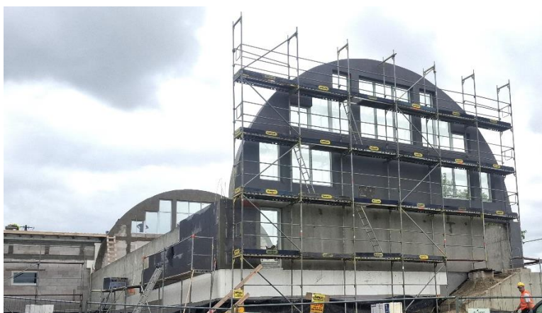
Zdjęcie nr 5. Sala gimnastyczna przy szkole w Będziemyślu w trakcie budowy
