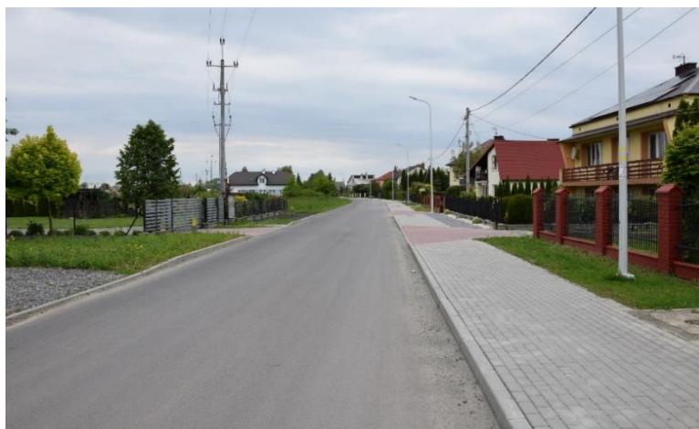
Zdjęcie nr 2. Przebudowana z wykorzystaniem pozyskanych środków zewnętrznych ulica Głowackiego (Osiedle Rędziny)
