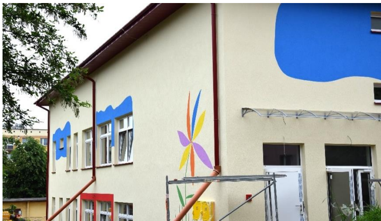
Zdjęcie nr 6. Żłobek Miejski w Sędziszowie Małopolskim w ostatnim etapie budowy
