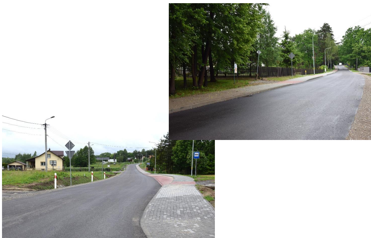
Zdjęcie nr 11. Największa inwestycja drogowa realizowana w 2024 r. – przebudowa drogi gminnej w m. Czarna Sędziszowska, za 8 mln zł na długości 4,3 km
