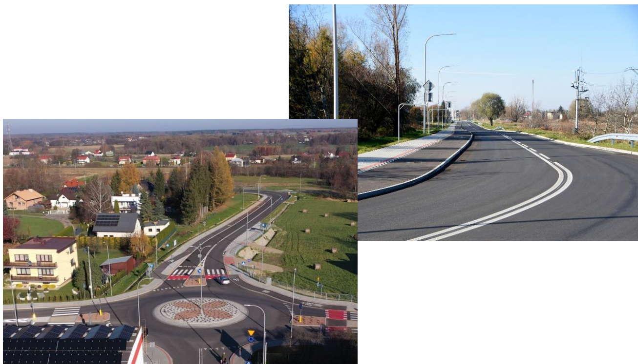
Zdjęcie nr 1. Największa inwestycja drogowa ostatnich lat - ulica kpt. Karola Chmiela z rondem, łącznie za blisko 11 mln zł, wybudowana w znacznej części z pozyskanych środków z Rządowego Funduszu Rozwoju Dróg
