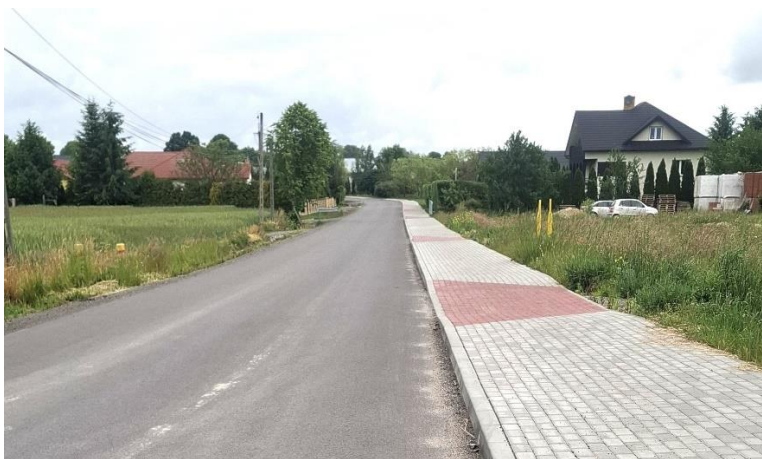
Zdjęcie nr 12. Przebudowana na odcinku ok. 1 km za 2,5 mln zł droga gminna Klęczany Majdan
