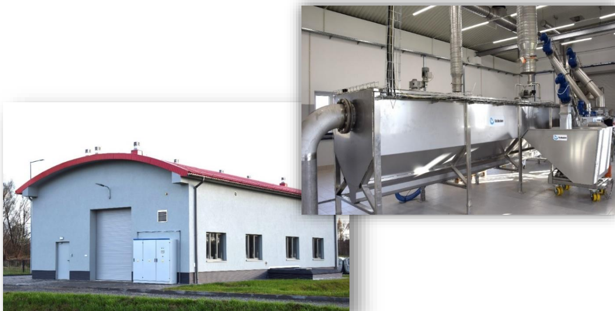
Zdjęcie nr 18. Kolejny zrealizowany etap rozbudowy gminnej oczyszczalni ścieków w Sędziszowie Małopolskim
