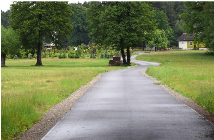
Zdjęcie nr 17. Przebudowana droga w Cierpiszu
