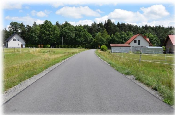
Zdjęcie nr 8. Ulica Poręby - Osiedle Borek Wielki po remoncie
