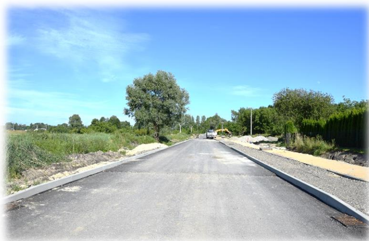
Zdjęcie nr 5. Największą inwestycją drogową w gminie w 2023 r. – budowa ulicy 1KZ za blisko 6,5 mln zł
