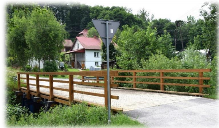
Zdjęcie nr 7. Most Szkodna-Budy po remoncie
